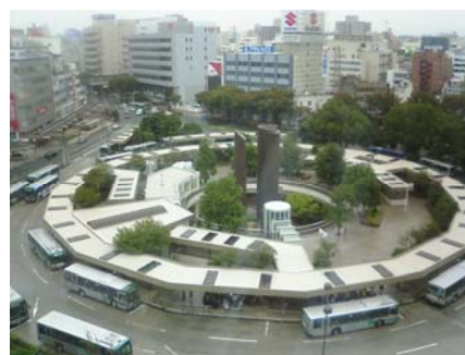
浜松駅北口バスロータリー
